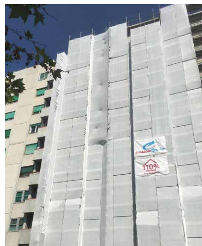
Riqualificazione energetica Via Vasco De Gama
