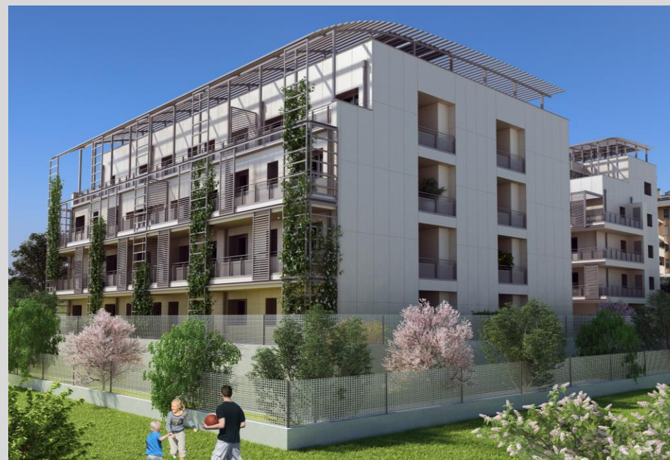
VISTA DAL PARCO
